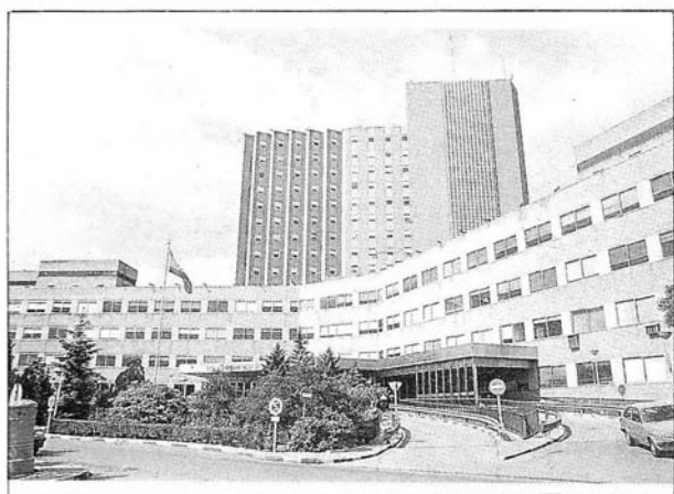
Sistema público de Salud. Instalaciones Sanitarias.
